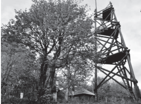
Nieistniejąca wieża na Baraniam
